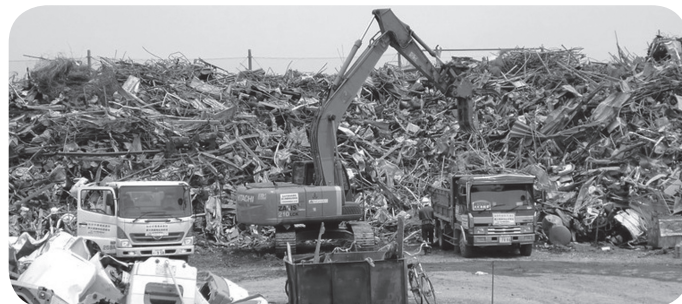
海岸地区3ヵ所に設置したがれき処理場
