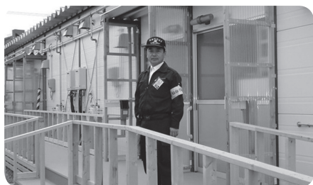
あすと長町に応急仮設住宅を整備。
